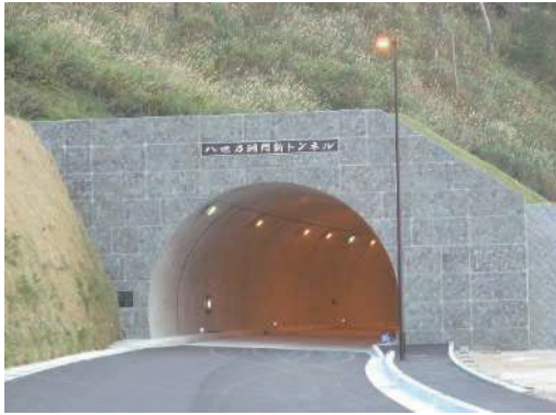
写真-23 珠洲側坑口 (完成時 石川県提供)
