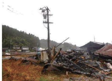
写真-1 工場における出火建物の様子 (七尾市) 2)
