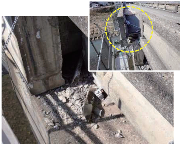
写真-7 桁の移動（桁軸直角方向）
