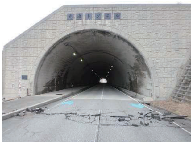
写真-4 光浦トンネル (輪島市鶴入側)
