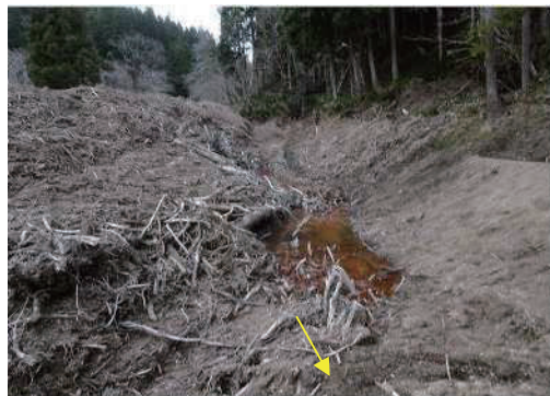
写真-6 河道閉塞 (谷内川)
