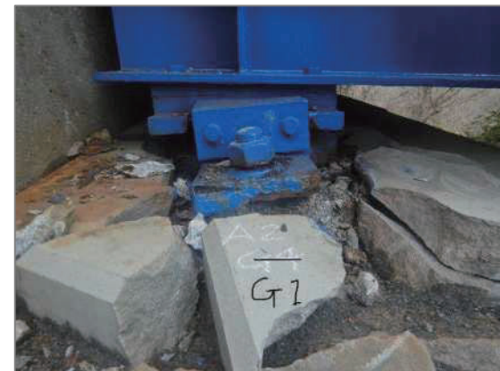
写真-30 沓座モルタルの破損・アンカーボルトの抜け出し・下沓の傾斜
