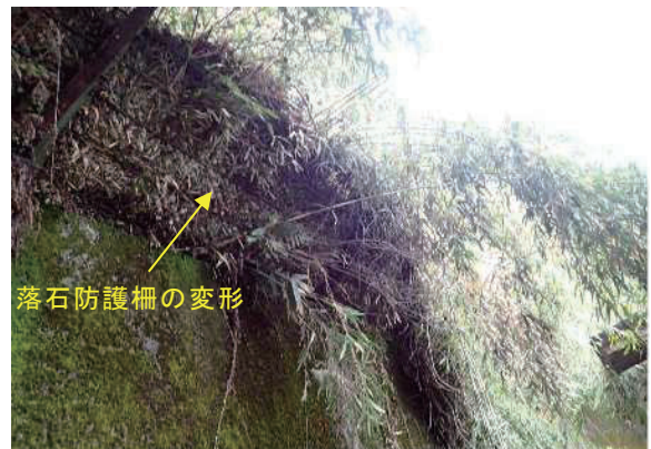
写真-8 既設落石防護柵の状況
