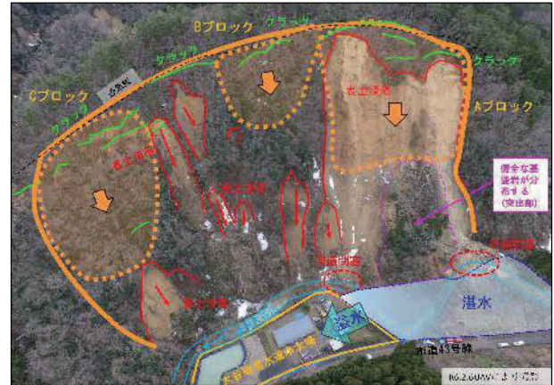
写真-1 被災状況
