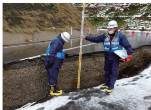
写真-9 町道栢木大福寺線の被災状況
