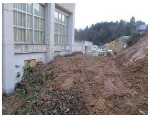
写真-10 小学校での大規模土砂崩れ
