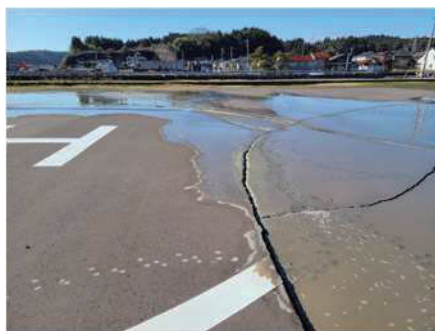
写真-6 穴水港の被災状況
