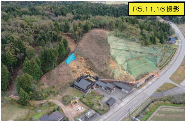
写真-4 現地状況【R5 対策工事直前】
