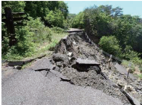
写真-1 山間部道路の路面崩壊
