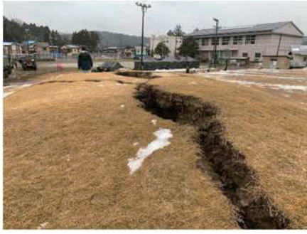
写真-4 公園の被災状況
