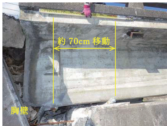
写真-10 桁の移動（桁軸方向）
