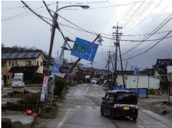
写真-1 内灘町液状化(石川県提供)
