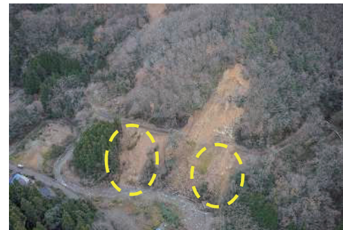
写真-5 増破による崩壊を追加(R6.11月撮影)
