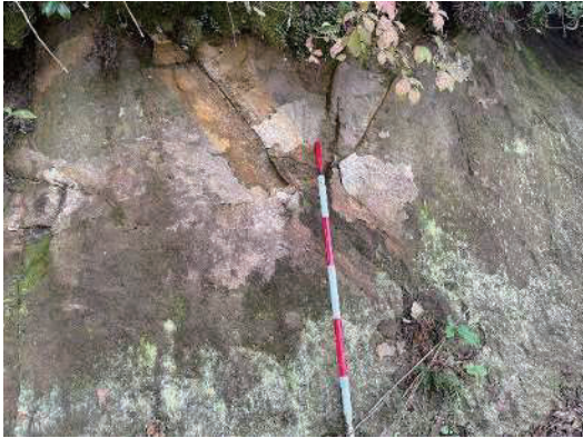
写真-3 露頭で確認される亀裂
