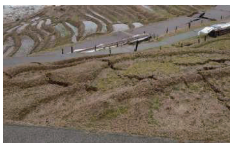
写真-1 白米千枚田の亀裂・法面崩壊
