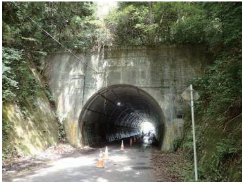
写真-28 長崎隧道
