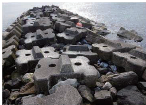
写真-3 津波によるブロックの散乱 (赤崎漁港)
