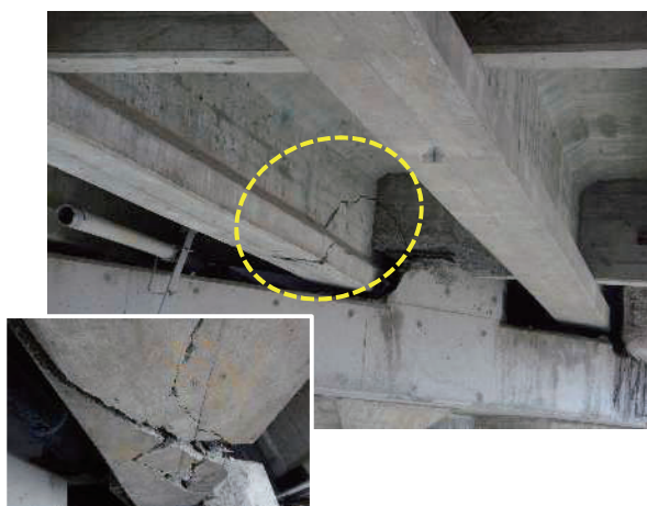
写真-9 桁の移動（桁軸直角方向）
