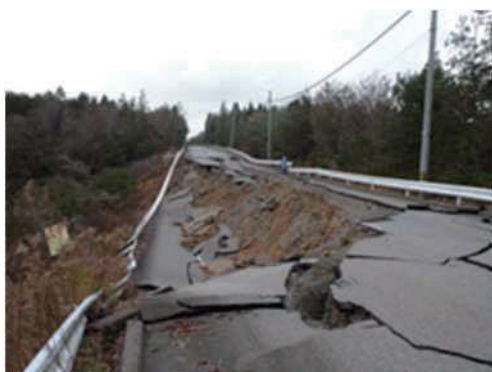
写真-7 荒屋輪島線の被災状況
