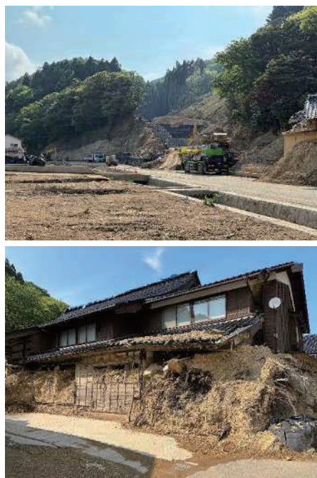
写真-5 珠洲市大谷町地内 9月豪雨後
