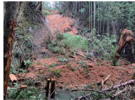
写真-8 農業用水路の被災状況
