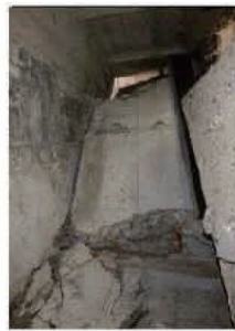
⑤橋桁 破断 一橋梁架替工
