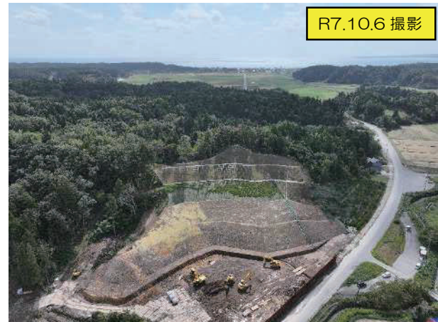
写真-6 R6 設計の工事状況
