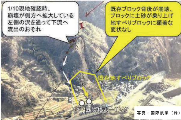
写真-1 珠洲市清水町地内の土砂災害(1)
