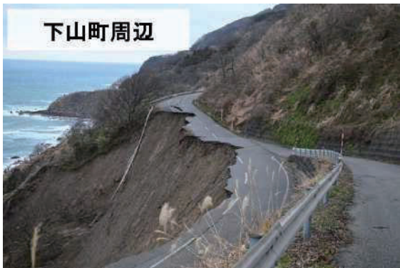
写真-3 斜面崩壊(国道 249 号) 3)
