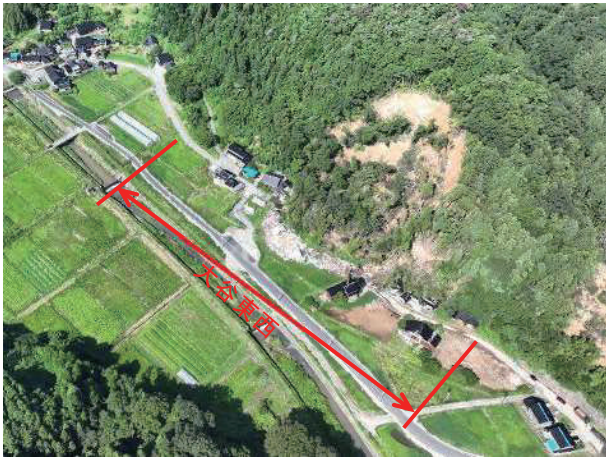
写真-1 大谷東西(珠洲市大谷町)の被災状況 写真出典：令和6年能登半島地震アーカイブ(提供者：石川県)/CC BY-NC-SA/改変済
