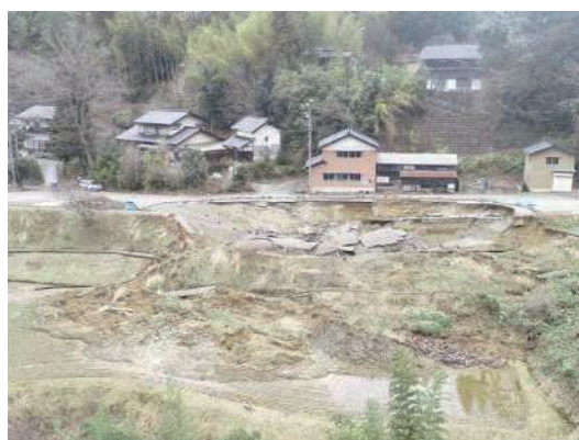
写真-2 盛土被災状況
