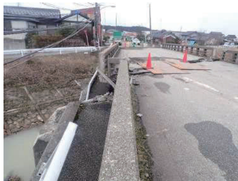
写真-4 車道部上部工の回転・移動
