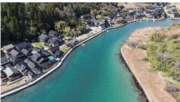
写真-7 河口に位置する穴水町の漁港
