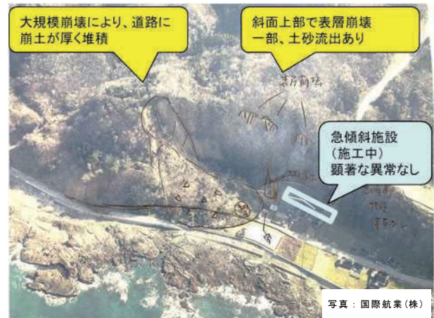
写真-3 珠洲市馬縹町地内の土砂災害
