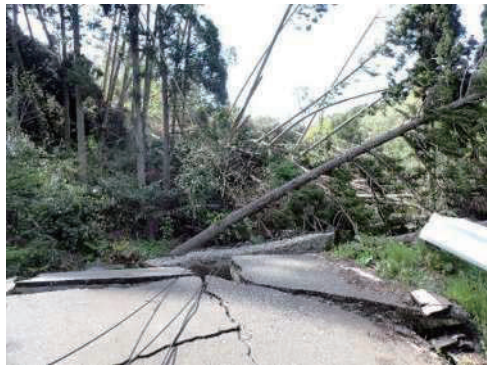
写真-1 山間部道路の路面崩壊
