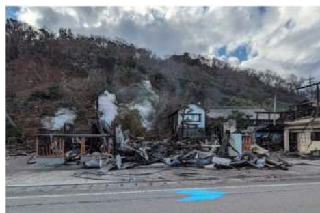
写真-2 ストーブ余熱の発火に伴う住宅火災 (輪島市) 3)
