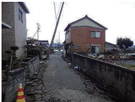
写真-5 液状化地区の被災状況
