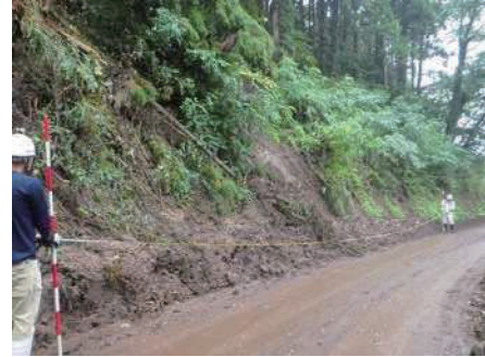
写真-3 増破による緊急調査の実施状況
