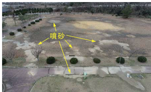
写真-1 公園内に発生した噴砂
