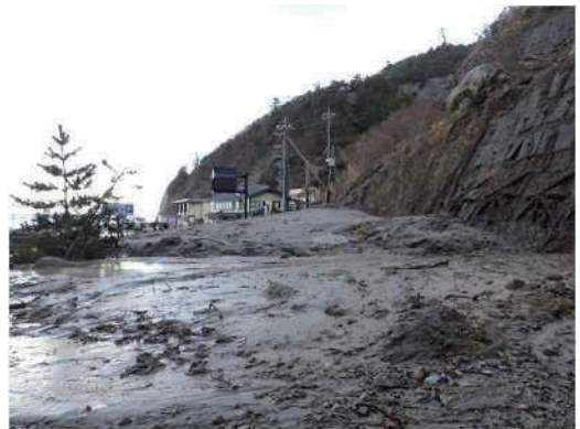
写真-27 珠洲方面の国道状況
