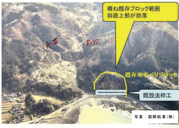
写真-2 珠洲市清水町地内の土砂災害(2)
