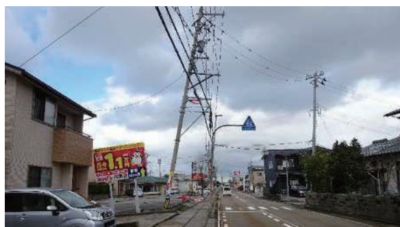
写真-7 電柱の傾き・沈下
