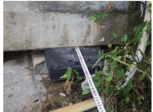
写真-8 ゴム支承の移動 (木保田橋)
