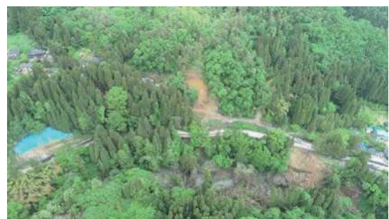
写真-2 UAVによる崩壊斜面の地形計測
