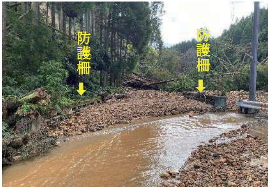
写真-50 橋面土砂堆積 (橋梁正面)
