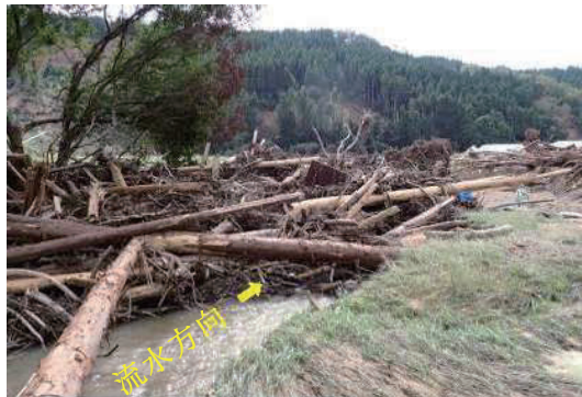
写真-52 河川断面閉塞 (橋梁上流側面)
