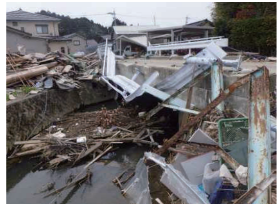
写真-48 防護柵の倒壊
