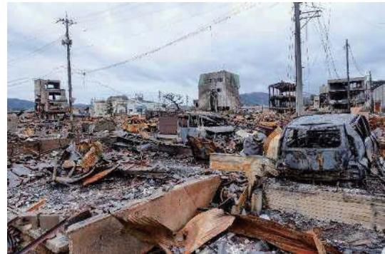
写真-5 輪島朝市の火災現場 7)
