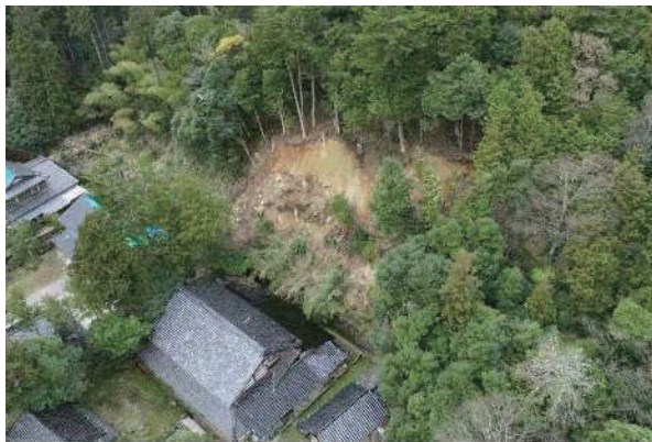
写真-5 崩壊箇所全景
