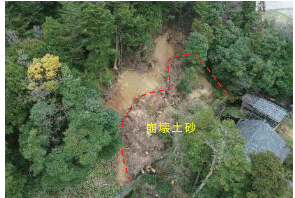
写真-7 残存する崩壊土砂
