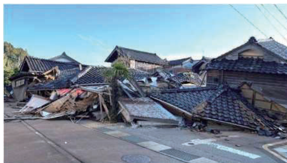
写真-1 建物の被災状況（中能登町金丸地内） （中能登町提供・上記行政視察資料より）
