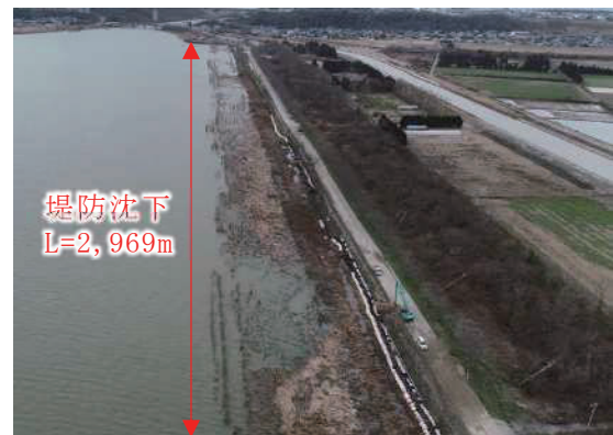
写真-4 河北潟正面堤防(湖西～湖南) (石川県提供)
