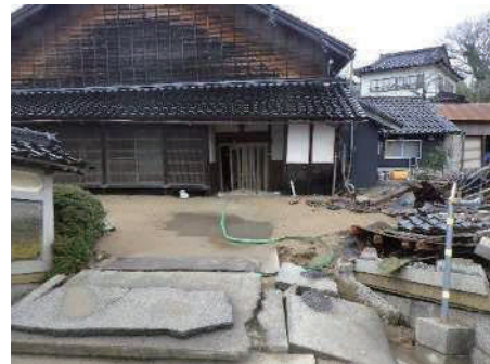
写真-14 液状化（噴砂）した民家の被災状況
