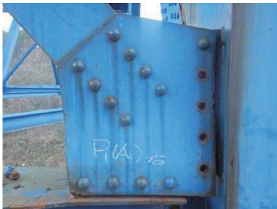
写真-3 リベットの破断
