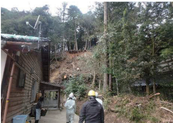
写真-9 合同現地調査の状況
