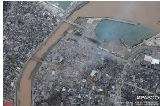
写真-4 輪島朝市火災現場空撮 6)
