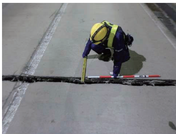
写真-7 舗装目地部の開口(100mm 程度)
