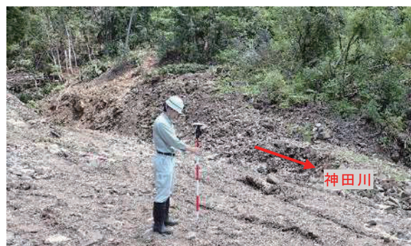
写真-3 RTKによる計測状況
