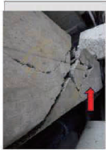
④格間主桁 破断 一橋梁架替工
