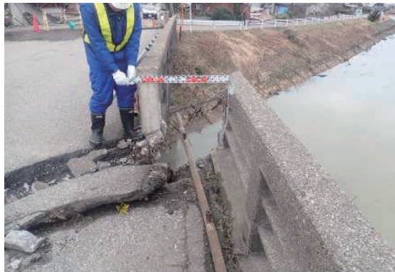
写真-8 桁の移動（桁軸直角方向）
