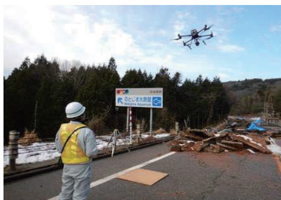
写真-4 UAV レーザ計測
