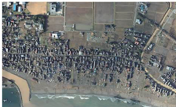
図-3 津波被害の状況(珠洲市宝立町付近) 4)
