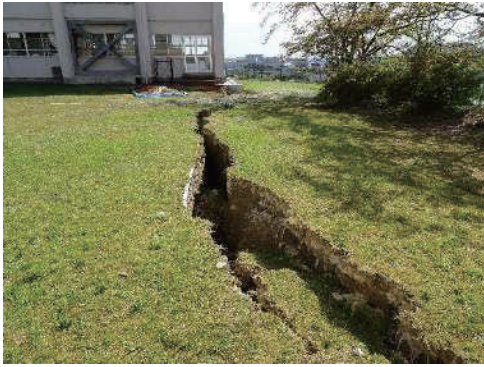
写真-11 中学校の校庭の大規模な地割れ
