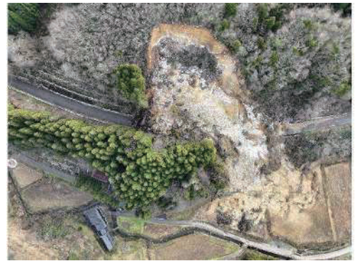
写真-7 地すべり全景 (久田4号線)
