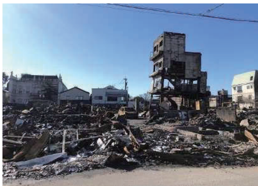
写真-1 朝市周辺火災（鎮火後） 1)
