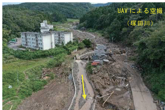
写真-6 豪雨による被災状況 提供：輪島市
